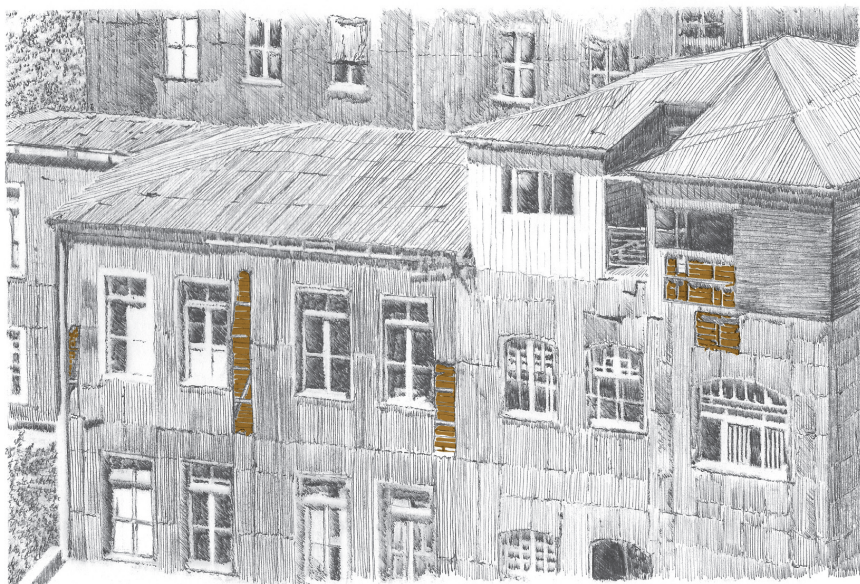
Fig.27: Adobillos a la vista en inmuebles
